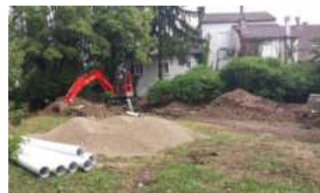
Les travaux s'élèvent à 105 000€ HT.
